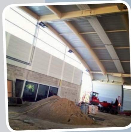
Chauffage au sol pour la salle polyvalente et le club-house. Radiateurs au plafond pour les courts de tennis couverts. Le tout alimenté par deux pompes à chaleur
