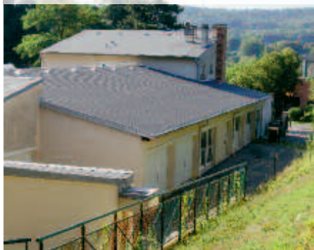
Rénovation du toit de l'école maternelle de Maillecourt.
