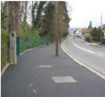
Rue Louis Scoccard (entre l'avenue du Maréchal Joffre et la rue des Hucheries) travaux de rénovation des trottoirs. Coût : 29 000 € TTC.
