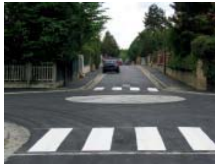
Rue du Parc Fin des travaux de réfection de la voirie.
