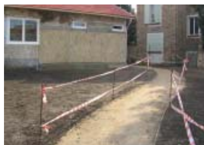
Rue de Paris rénovation du local destiné à l'association Appel Détresse. Coût : 50 000 €.
