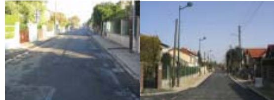
Avenue des Bleuets travaux de réfection de la voirie et des réseaux. La deuxième phase commencera cet été (entre Esterel et le fond de Mondétour).
