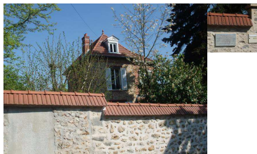
10, rue des Sablons
