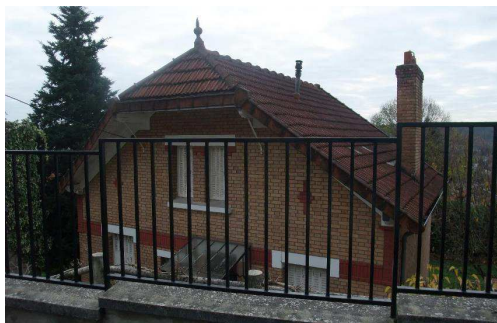
5, rue de Châteaufort
